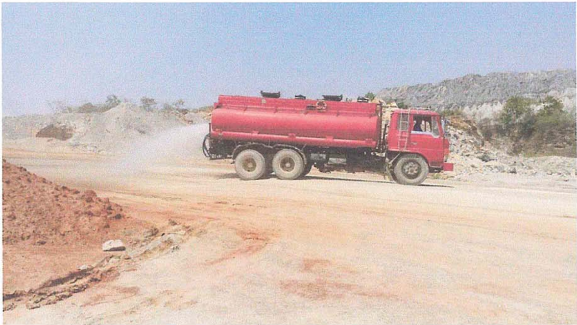
รูปที่ 3 แสดงการใช้รถน้ำราดถนนในเหมืองเพื่อลดฝุ่นฟุ้งกระจาย
