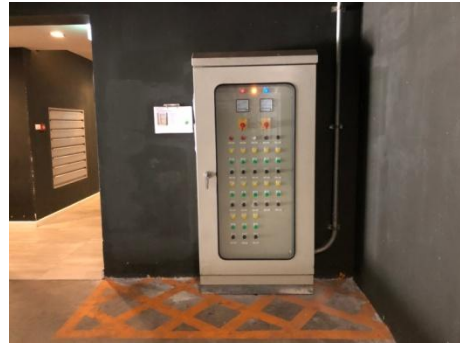
รูปที่ 2-28 ตู้บำบัดน้ำเสียของโครงการ
