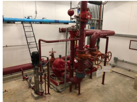
รูปที่ 2-24 เครื่องปั๊มน้ำดับเพลิง
