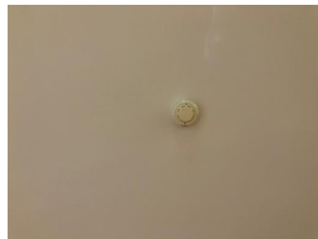
รูปที่ 2-8 อุปกรณ์ตรวจจับควัน
