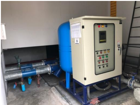
รูปที่ 2-23 เครื่องปั๊มน้ำขึ้นดาดฟ้า
