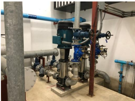
รูปที่ 2-25 เครื่องปั๊มน้ำขึ้นใต้ดิน
