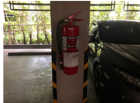
รูปที่ 2-9 ถังดับเพลิงชนิดมือถือพร้อมคำแนะนำการใช้งาน
