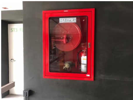
รูปที่ 2-5 ตู้เก็บสายฉีดน้ำดับเพลิง
