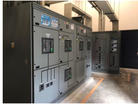
รูปที่ 2-20 ห้องแผงจ่ายไฟฟ้า (MDB)
