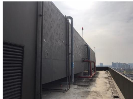
รูปที่ 2-26 ถังเก็บน้ำดาดฟ้า
