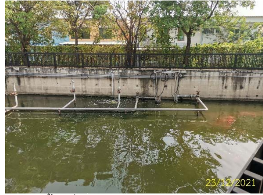
จัดให้มีบ่อป้อม (Polishing Pond) ซึ่งมีการติดตั้งเครื่องเติมอากาศ
