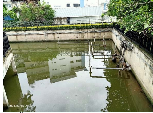
บ่อพักน้ำด้านหน้าโครงการมีการติดตั้งเครื่องเติมอากาศ
