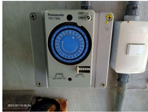
Timer ควบคุมการเปิดปิดไฟ ภาพที่ 2.2-12 (ต่อ) ระบบไฟฟ้าภายในโครงการ
