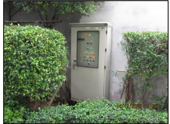
ภาพที่ 2-8 ตู้ควบคุมระบบน้ำเสียที่ผ่านการบำบัดแล้วไปรดน้ำต้นไม้
