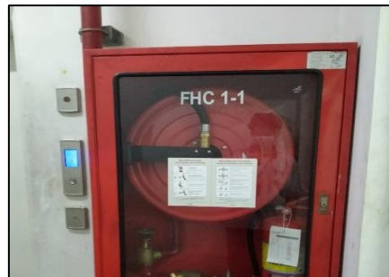
ข. ตู้เก็บสายฉีดน้ำดับเพลิงพร้อมอุปกรณ์
