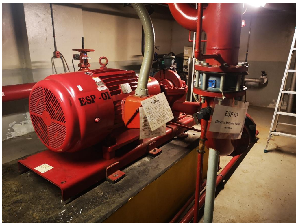
รูปที่ 2-7 เครื่องสูบน้ำดับเพลิงแบบขับเคลื่อนด้วยไฟฟ้า
