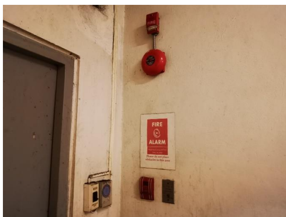
รูปที่ 3-5 ระบบส่งสัญญาณแจ้งเหตุเพลิงไหม้ชนิดเปล่งเสียง
