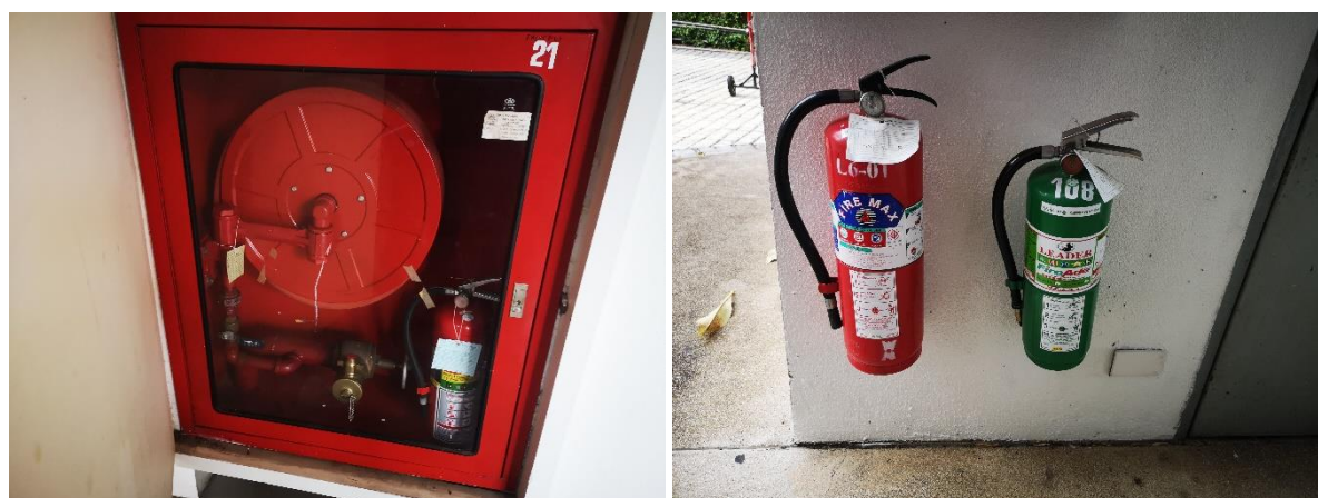
รูปที่ 3-8 ตู้ดับเพลิงและเครื่องดับเพลิงแบบมือถือ
