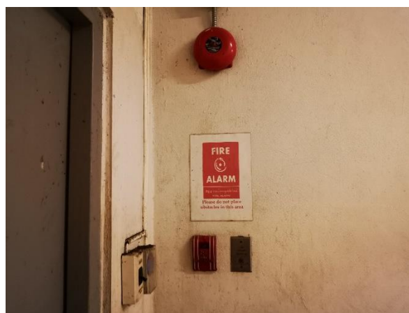
รูปที่ 3-5 ระบบส่งสัญญาณแจ้งเหตุเพลิงไหม้ชนิดเปล่งเสียง
