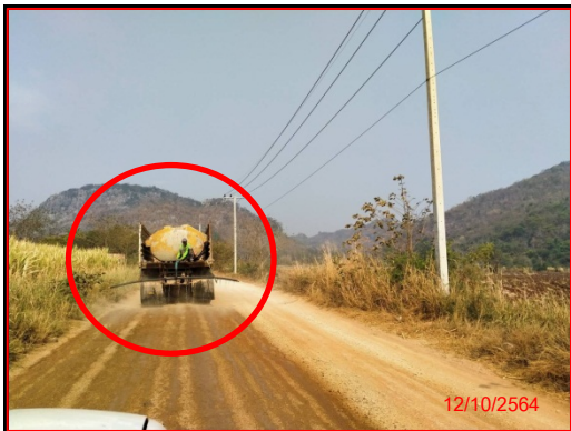
การฉีดพรมน้ำเส้นทางขนส่งแร่
