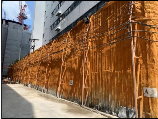
ภาพที่ 47 รั้วแผ่นโฟมกันเสียงรอบโครงการ
