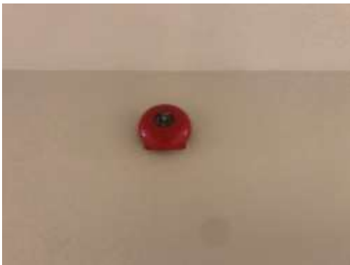
รูปที่ 2-10 กริ่งแจ้งเตือนเหตุฉุกเฉิน
