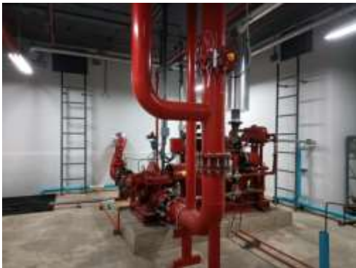
รูปที่ 2-12 ปั๊มน้ำดับเพลิง
