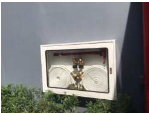
รูปที่ 2-6 หัวจ่ายน้ำดับเพลิงและสายส่งน้ำ
