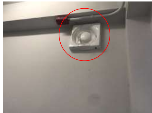
รูปที่ 2-19 พัดลมระบายอากาศในห้องพักขยะ
