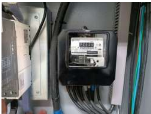
รูปที่ 2-49 มิเตอร์ไฟฟ้าของระบบบำบัดน้ำเสีย
