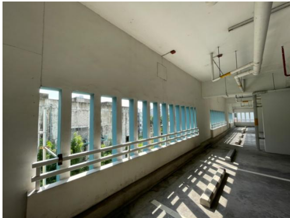
รูปที่ 2-63 มีการออกแบบให้ชั้นลานจอดรถ สามารถระบายอากาศได้
