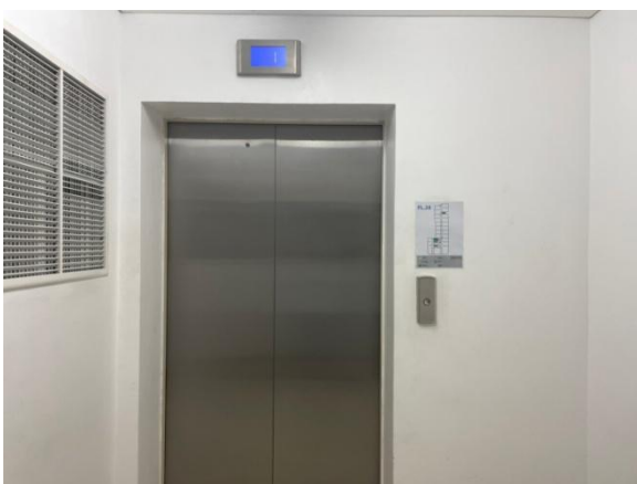
รูปที่ 2-25 ลิฟต์ดับเพลิง
