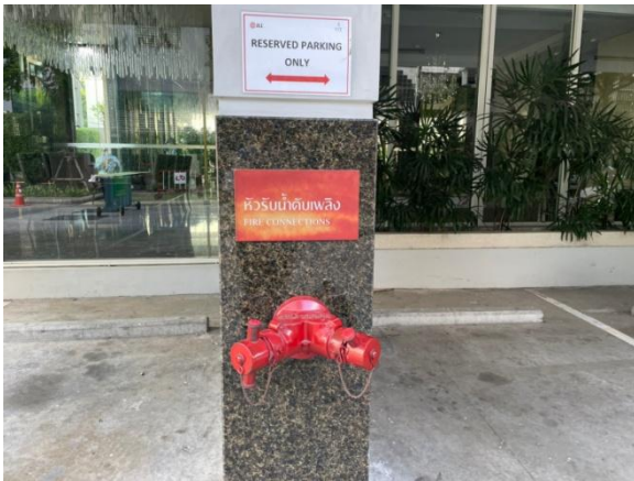
รูปที่ 2-21 ห้รับน้ำดับเพลิง
