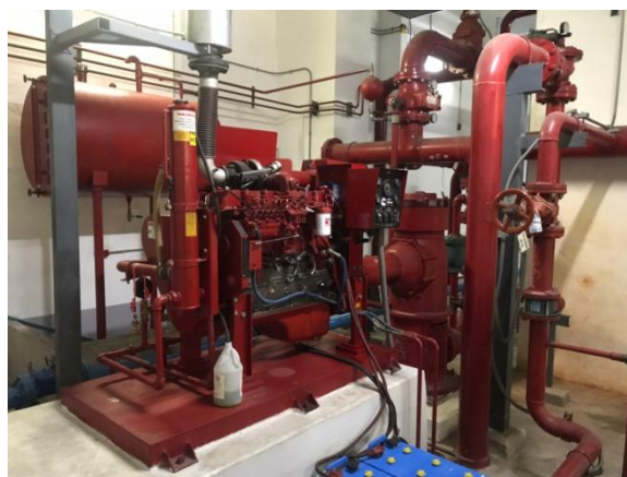
รูปที่ 2-20 เครื่องสูบน้ำดับเพลิง (Fire Pump)
