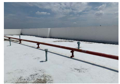
ที่ระบายอากาศระบบบำบัดน้ำเสีย
