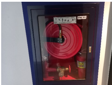
ตู้เก็บสายดับเพลิงและอุปกรณ์
