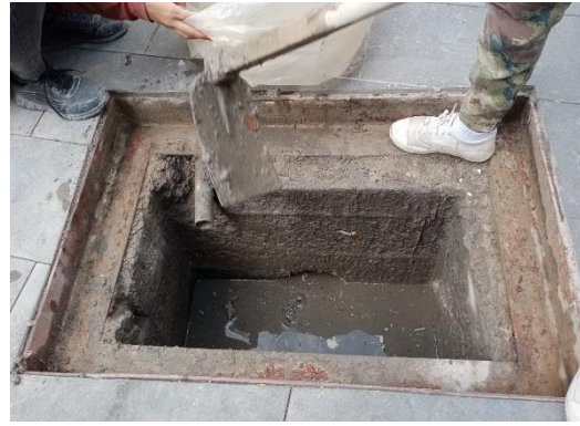
ชุดลอกตะกอนดินของบ่อพักน้ำ
