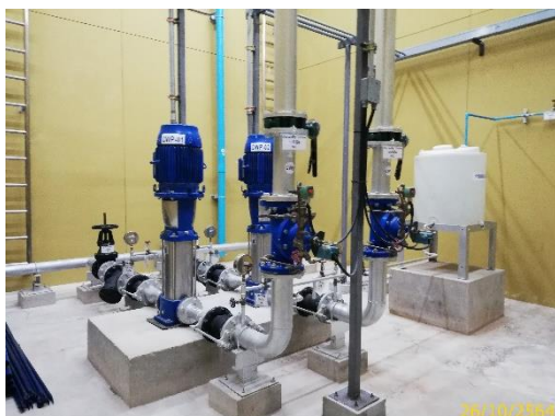
เครื่องสูบน้ำขึ้นใต้ดิน
