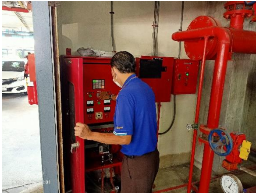
เจ้าหน้าที่ตรวจสอบปั้มสูบน้ำดับเพลิง
