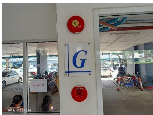
Fire Alarm Manual Station และ Alarm Bell
