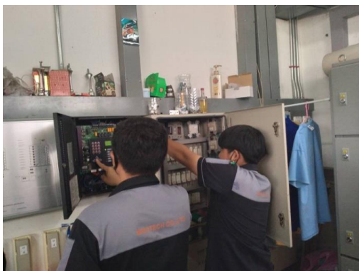
เจ้าหน้าที่ตรวจสอบ Fire Alarm Control Panel : FCP
