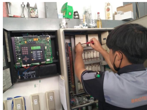
เจ้าหน้าที่ตรวจสอบ Fire Alarm Control Panel : FCP
