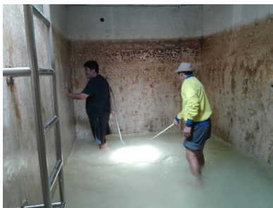
การทำความสะอาดถึงเก็บน้ำใช้
