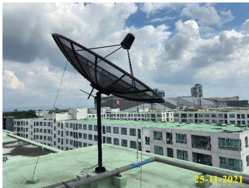
ภาพที่ 1.3.12-1 ระบบรับสัญญาณโทรทัศน์
