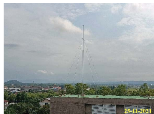
ภาพที่ 1.3.9-2 ระบบป้องกันฟ้าผ่า
