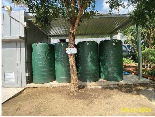
ภาพที่ 1.3.4-2 ระบบ Reuse น้ำทิ้งหลังบำบัดมาใช้รดต้นไม้
