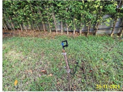
ภาพที่ 1.3.4-2 ระบบ Reuse น้ำทิ้งหลังบำบัดมาใช้รดต้นไม้
