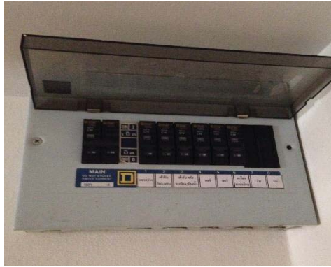
ระบบตัดกระแสไฟฟ้าอัตโนมัติ
