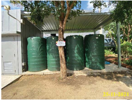
ระบบ Reuse น้ำทิ้งหลังบำบัดมาใช้รดต้นไม้
