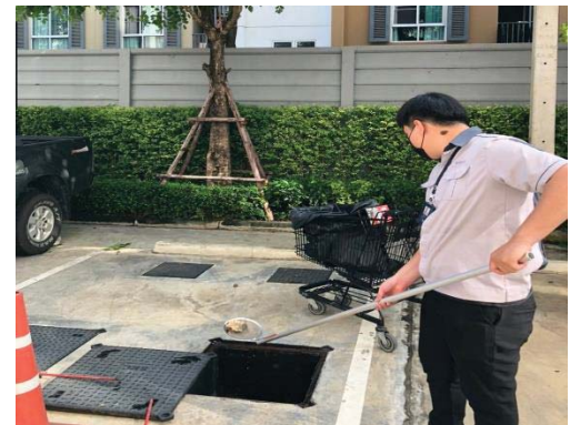
ภาพที่ 1.3.4-4 ตักไขมันจากบ่อดักไขมัน
