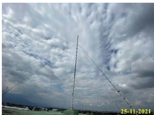
ภาพที่ 1.3.9-2 ระบบป้องกันฟ้าผ่า
