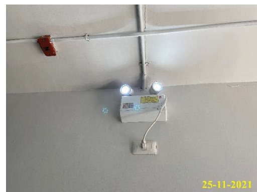
ภาพที่ 1.3.7-2 ไฟส่องสว่างฉุกเฉิน
