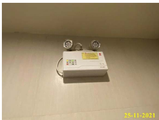
ภาพที่ 1.3.7-2 ไฟส่องสว่างฉุกเฉิน
