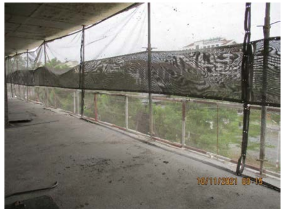
รูปที่ 2-13 ผ้าใบกันฝุ่น (Mesh Sheet)
