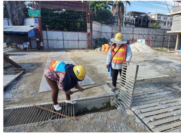
รูปที่ 2-23 ขุดลอกบ่อดักตะกอน/รางระบายน้ำ
