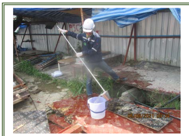
รูปที่ 3-14 การเก็บตัวอย่างคุณภาพน้ำทั้ง บริเวณบ่อพักน้ำทั้งชั่วคราวสุดท้ายก่อนระบาย ออกกระบบระบายน้ำทิ้งสาธารณะ
