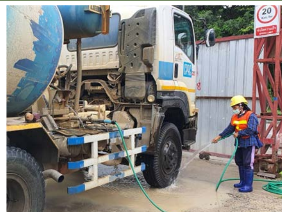
รูปที่ 2-8 ป่อล้างล้อรถ
