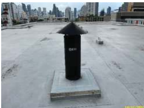
ท่อระบายอากาศห้องเครื่องกำเนิดไฟฟ้าสำรอง
