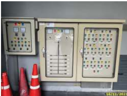
ตู้ควบคุมระบบบำบัดน้ำเสียเบื้องต้น ชุดที่ 1 และระบบบำบัดน้ำเสียขั้นสุดท้าย
