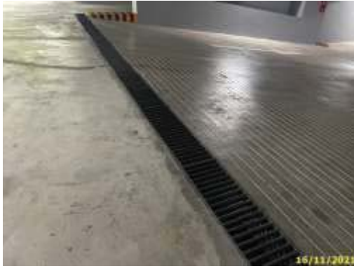
รางระบายน้ำพร้อมด้วยตะแกรงเหล็กครอบ
