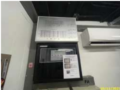
แผงควบคุมระบบเตือนอัคคีภัย
