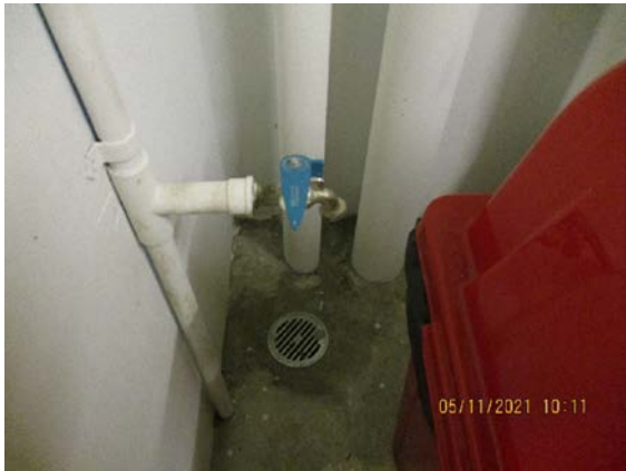
รูปที่ 2-56 ตะแกรงครอบรูท่อระบายน้ำ
