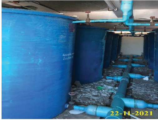
ถังเก็บน้ำชั้นตาดฟ้าอาคาร C
