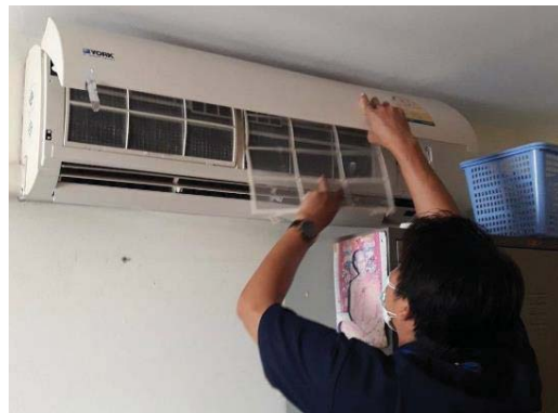
ภาพที่ 2.2-5 เจ้าหน้าที่ล้างเครื่องปรับอากาศ
