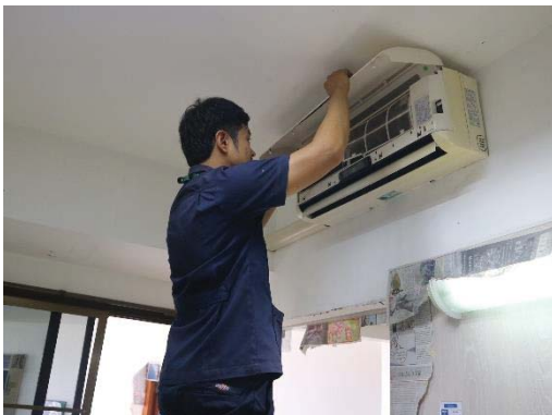
ภาพที่ 2.2-5 เจ้าหน้าที่ล้างเครื่องปรับอากาศ
