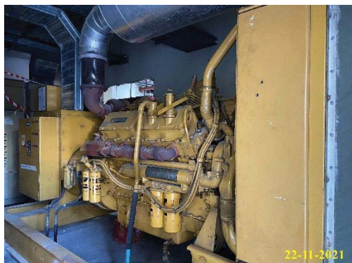
ภาพที่ 2.2-11 เครื่องกำเนิดไฟฟ้าสำรอง
