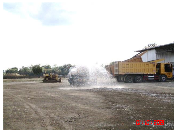
รูปที่ 2-11 การฉีดพรมน้ำเพื่อลดการฟุ้งกระจายของฝุ่นละออง
