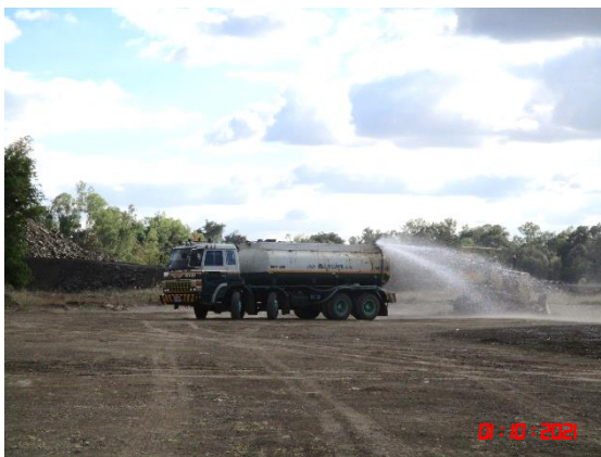
รูปที่ 2-11 การฉีดพรมน้ำเพื่อลดการฟุ้งกระจายของฝุ่นละออง
