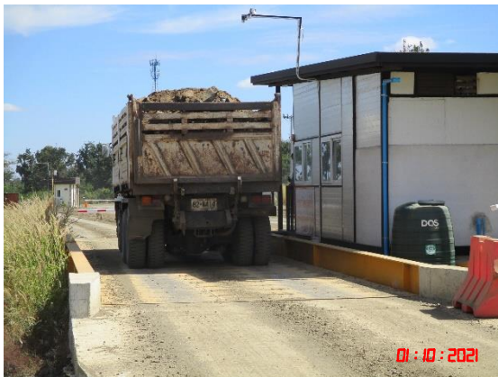
รูปที่ 2-11 การฉีดพรมน้ำเพื่อลดการฟุ้งกระจายของฝุ่นละออง
