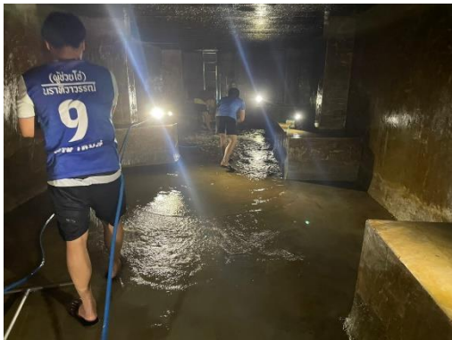
ภาพที่ 2.2-11 ทำความสะอาดถังน้ำใช้
