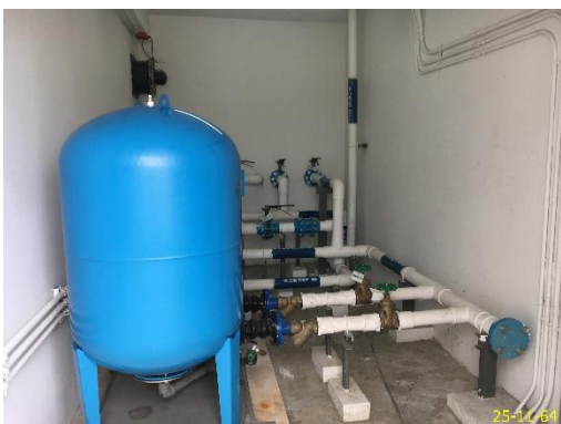
ปั้มน้ำ และถังเก็บน้ำสำรองชั้นดาดฟ้า อาคาร B ภาพที่ 2.2-9 (ต่อ) ระบบน้ำใช้
