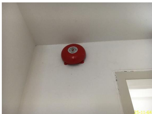
อุปกรณ์ส่งสัญญาณเพื่อให้หนีไฟ
