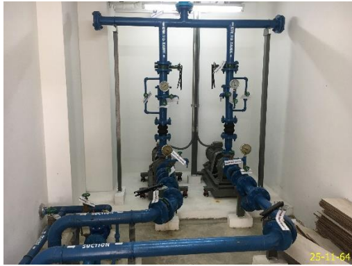
ปั้มน้ำ และถังเก็บน้ำสำรองชั้นใต้ดิน อาคาร D
