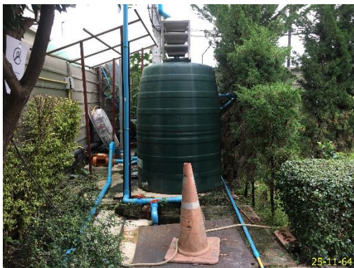
บ่อกักน้ำสุดท้ายก่อนปล่อยออก ภาพที่ 2.2-6 (ต่อ) ระบบบำบัดน้ำเสียโครงการ
