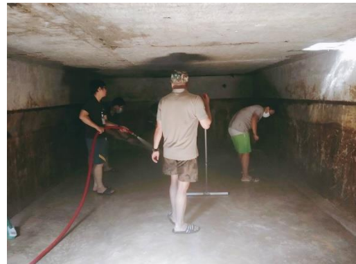
ภาพที่ 2.2-11 ทำความสะอาดถังน้ำใช้
