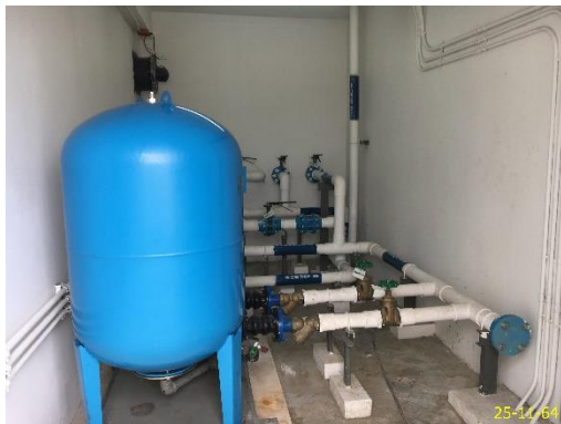
ปั้มน้ำ และถังเก็บน้ำสำรองชั้นดาดฟ้า อาคาร B
