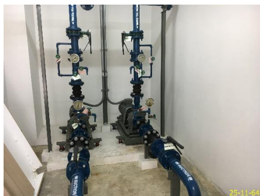
ปั้มน้ำ และถังเก็บน้ำสำรองชั้นใต้ดิน อาคาร A ภาพที่ 2.2-9 (ต่อ) ระบบน้ำใช้
