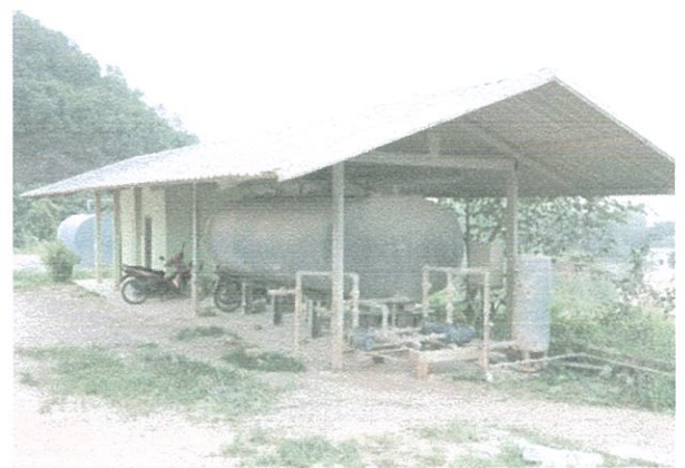
รูปที่ 17 ถังเก็บน้ำสำหรับสเปรย์น้ำในโรงโม่หิน
