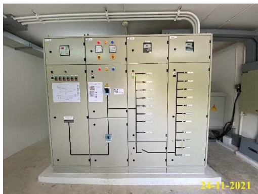
Main Distribution Board อาคาร A
