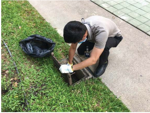
ตรวจสอบท่อระบายน้ำและชุดลอกตะกอนดิน ภาพที่ 2.2-7 (ต่อ) ระบบระบายน้ำและป้องกันน้ำท่วม
