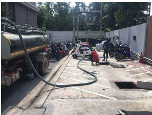
ดูดำจัดจัตตะกอนระบบบำบัดน้ำเสีย
