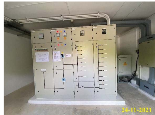
Main Distribution Board อาคาร B
