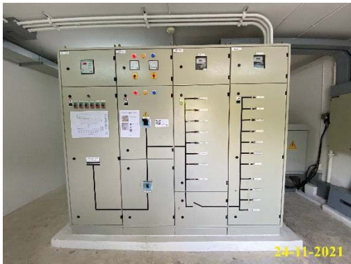
Main Distribution Board อาคาร A
