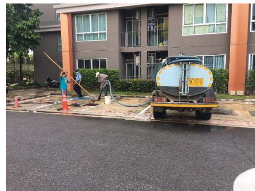
ดูดำจัดจัตตะกอนระบบบำบัดน้ำเสีย
