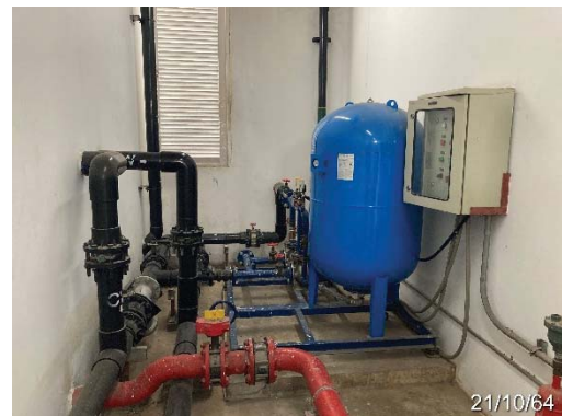
ระบบสำรองและจ่ายน้ำขึ้นดาดฟ้า
