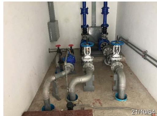
ระบบสำรองและจ่ายน้ำขึ้นใต้ดิน
