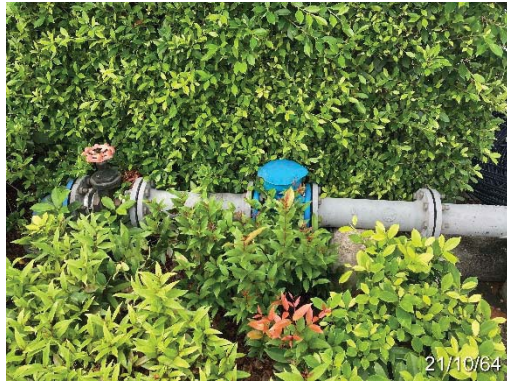
มิเตอร์รับน้ำจากการประปานครหลวง
