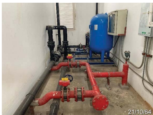
ระบบสำรองและจ่ายน้ำขึ้นดาดฟ้า
