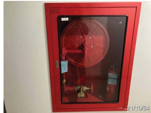
ตู้เก็บสายฉีดน้ำดับเพลิง/ถังดับเพลิง
