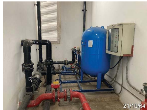
ระบบสำรองน้ำและจ่ายน้ำชั้นดาดฟ้า
