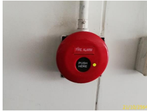
อุปกรณ์แจ้งเหตุด้วยมือ Manual Station
