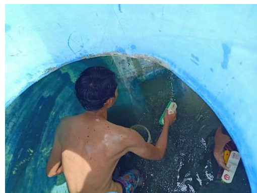
ล้างทำความสะอาดถังเก็บน้ำ
