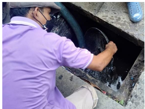
สูบลบตะกอนระบบบำบัดน้ำเสีย
