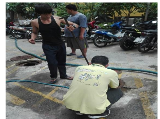
สูบลบตะกอนระบบบำบัดน้ำเสีย
