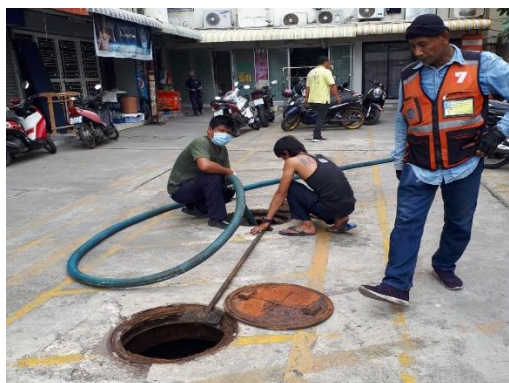
สูบลบตะกอนระบบบำบัดน้ำเสีย
