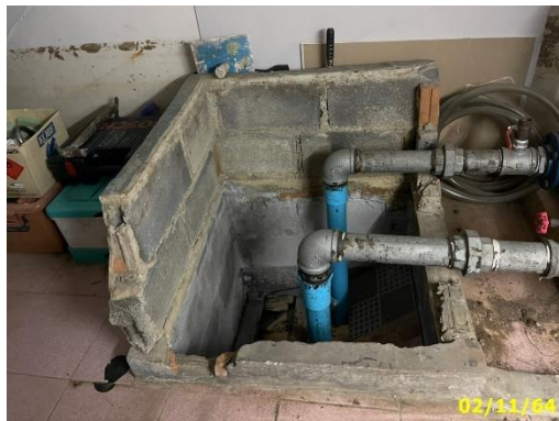
ถังเก็บน้ำใต้ดิน พร้อมเครื่องปั้มน้ำ
