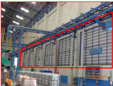
ภาพที่ 2-2 ระบบระบายอากาศในอาคาร บริเวณที่มีความร้อนสูง
