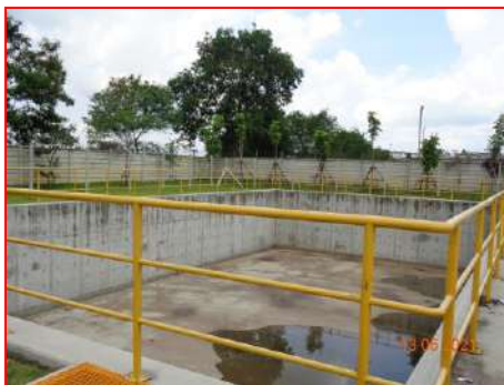
ภาพที่ 2-30 บ่อกักเก็บน้ำฝนของโครงการ
