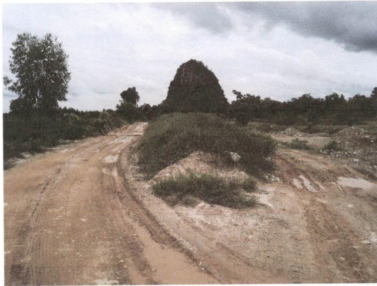
รูปที่ 5 แสดงคันทำนบกิน โดยใช้เศษหินและดินปรับแต่งเป็นแนวคันทำนบก บริเวณด้านตะวันออกทางเข้าโครงการฯ
