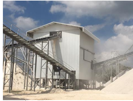
รูปที่ 2-18: การปิดคลุมอาคารโรงโม่
