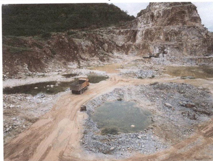
รูปที่ 3 แสดงถนนในโครงการฯ เป็นถนนดินลูกรังอัดแน่น
