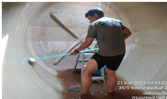
รูปที่ 47 ทำความสะอาดถังเก็บน้ำฝนดาดฟ้า และชั้นใต้ดิน
