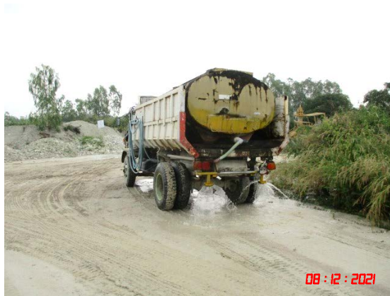
รูปที่ 2-5 การฉีดพรมน้ำบริเวณเส้นทางขนส่งแร่
