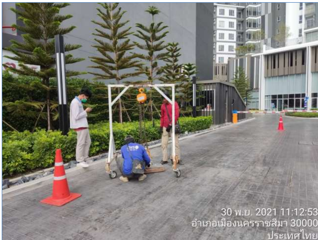
ภาพที่ 3-2(2.1) ช่างอาคารตรวจสอบบ่อพักน้ำเดือนละ 1 ครั้ง ถ้ามีตะกอนให้สูบตะกอนทิ้ง (ต่อ)
