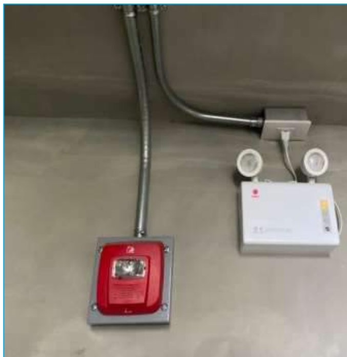
ภาพที่ 2-4(4.5-5) ไฟส่องสว่างฉุกเฉิน
