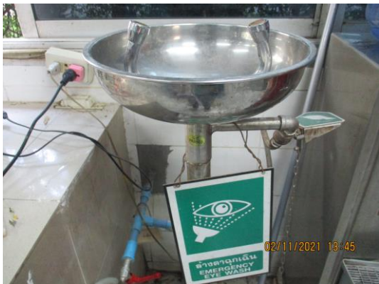
รูปที่ 45 ฝักบัวและอ่างล้างตา
