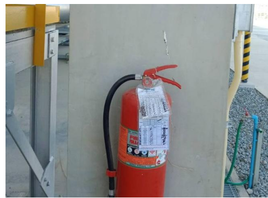
รูปที่ 3-7 ถังดับเพลิงแบบผงเคมีแห้งและป้ายแสดงการตรวจสอบสภาพถังดับเพลิง บริเวณสถานีควบคุมความดันและวัดปริมาณก๊าซธรรมชาติ (MRS)
