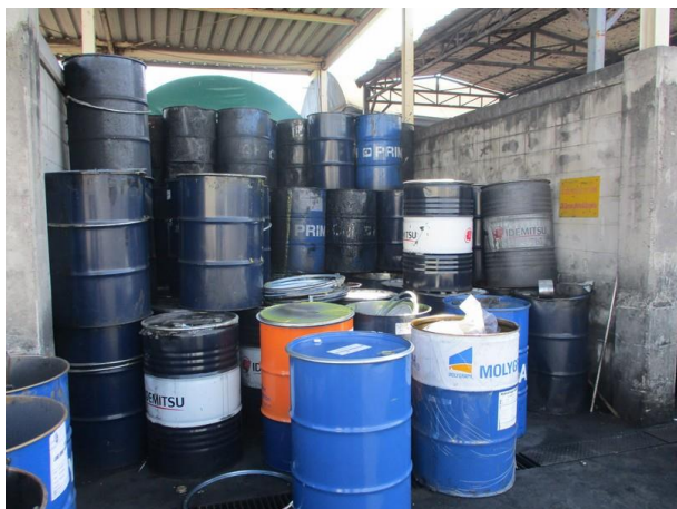
รูปที่ 2-43 ภาพขณะรองรับการถ่ายน้ำมัน ที่มีฝาปิดมิดชิด และเคลื่อนย้ายไปเก็บที่โรงเก็บของเสียอันตรายพร้อมติดป้ายชี้บ่ง
