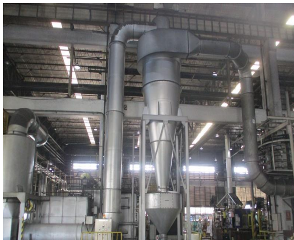
รูปที่ 2-1 ระบบบำบัดมลพิษทางอากาศแบบไซโคลนเพื่อบำบัดมลพิษทางอากาศที่เกิดจากเครื่องทุบขึ้นรูปขนาด 6300 ตัน
