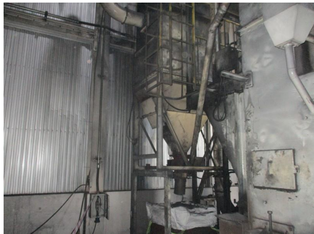
รูปที่ 2-37 ระบบบำบัดมลพิษทางอากาศแบบถุงกรอง ของเครื่องขัดผิวขึ้นงาน
