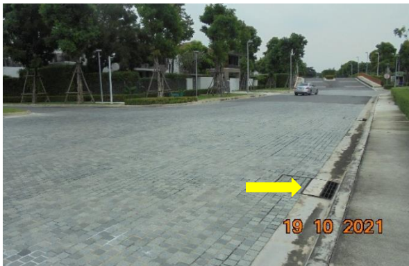
รูปที่ 2-14 ตะแกรงดักเศษขยะ
