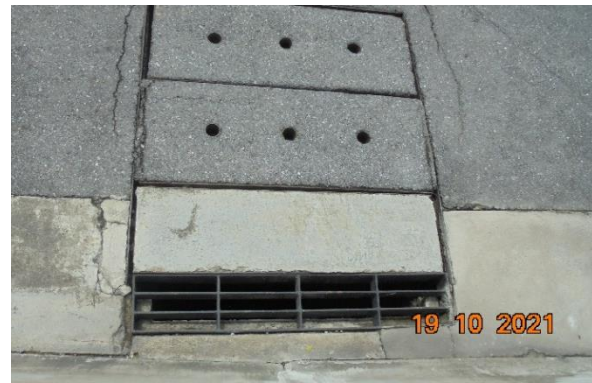
รูปที่ 2-14 ตะแกรงดักเศษขยะ
