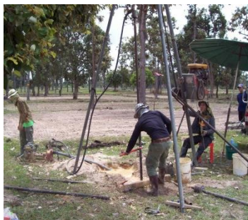
ขั้นตอนที่ 2 - 4 งานเจาะสำรวจชั้นดินและงานก่อสร้างฐานราก
