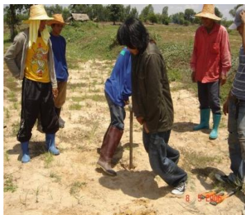
ขั้นตอนที่ 2 - 4 งานเจาะสำรวจชั้นดินและงานก่อสร้างฐานราก
