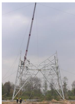
ขั้นตอนที่ 5 งานติดตั้งเสาโครงเหล็กและแขวนลูกถ้วยเตรียมงานชิงสาย
