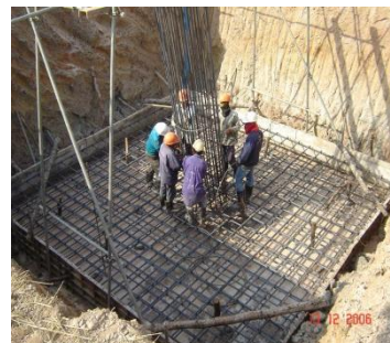
ขั้นตอนที่ 2 - 4 งานเจาะสำรวจชั้นดินและงานก่อสร้างฐานราก
