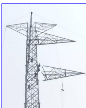
ขั้นตอนที่ 5 งานติดตั้งเสาโครงเหล็กและแขวนลูกถ้วยเตรียมงานชิงสาย
