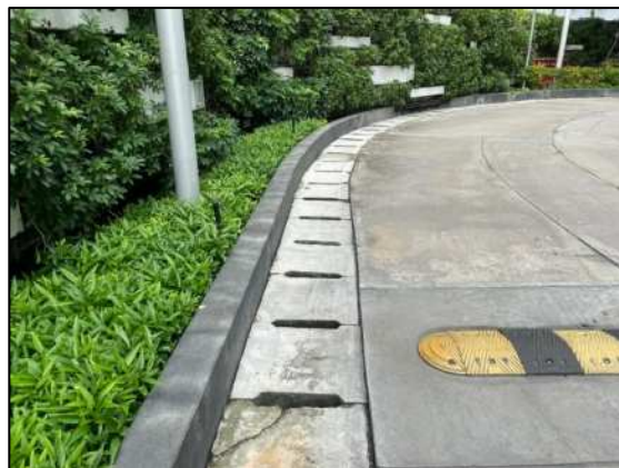
รูปที่ 2-15 ท่อระบายน้ำรองรับน้ำหลากภายในโครงการ
