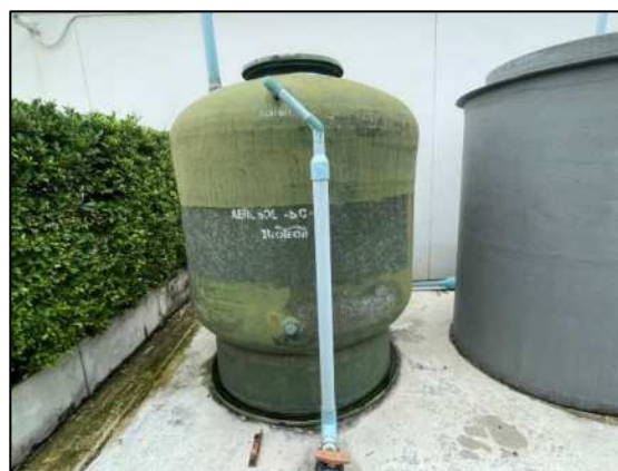
รูปที่ 2-10 ถังเก็บก๊าซมีเทน
