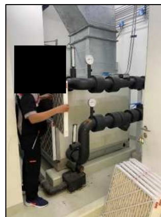
รูปที่ 2-22 การทำความสะอาดแผ่นกรองอากาศด้านหน้า และแผ่นระบายความร้อน
