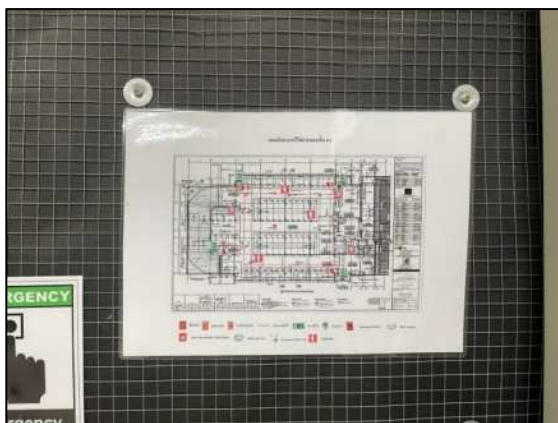
รูปที่ 2-32 การติดตั้งแบบแปลนแผนผังของอาคารแต่ละชั้นแสดงตำแหน่งที่ติดตั้งอุปกรณ์ดับเพลิงต่างๆ
