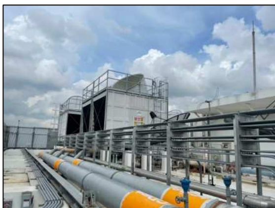
รูปที่ 2-35 ติดตั้งห่อระบายความร้อนบริเวณดาดฟ้าโครงการ
