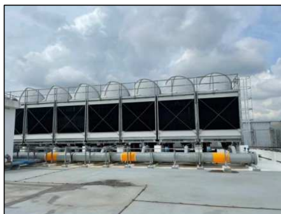
รูปที่ 2-35 ติดตั้งห่อระบายความร้อนบริเวณดาดฟ้าโครงการ
