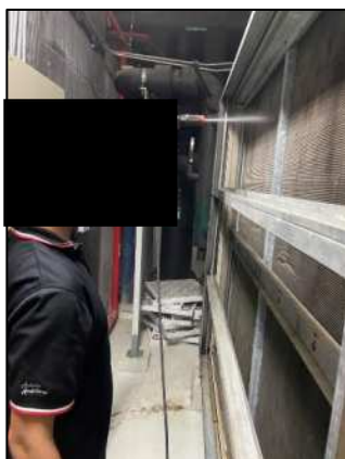
รูปที่ 2-22 การทำความสะอาดแผ่นกรองอากาศด้านหน้า และแผ่นระบายความร้อน
