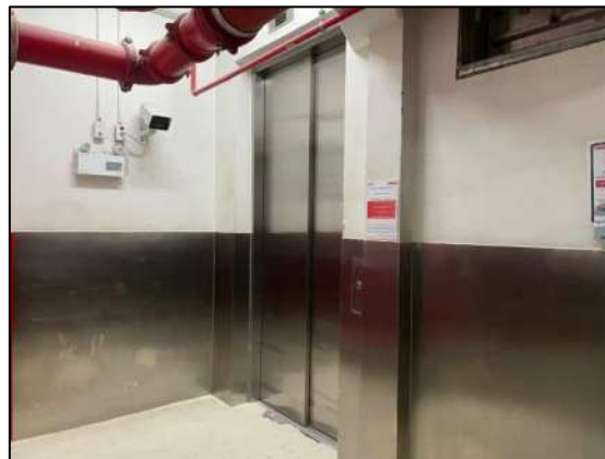
รูปที่ 2-28 ลิฟต์ดับเพลิง
