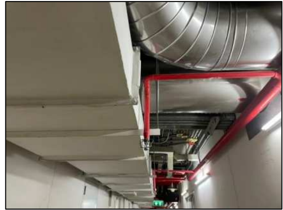
รูปที่ 2-27 ระบบหัวกระจายน้ำดับเพลิง อัตโนมัติ (Automatic Sprinkler System)
