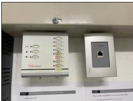
รูปที่ 2-23 ติดตั้งเครื่องปรับระดับแสงสว่าง (Dimmer) และหลอดไฟ
