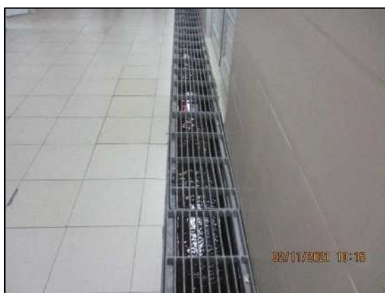
รูปที่ 2-44 ตะแกรงครอบตามรูท่อระบายน้ำทั้งภายในและภายนอกอาคาร
