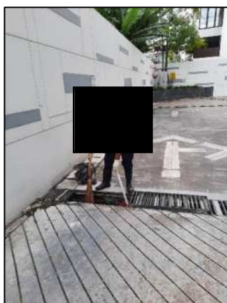
รูปที่ 2-16 ทำความสะอาดและลอกท่อระบายน้ำเป็นประจำทุกเดือน
