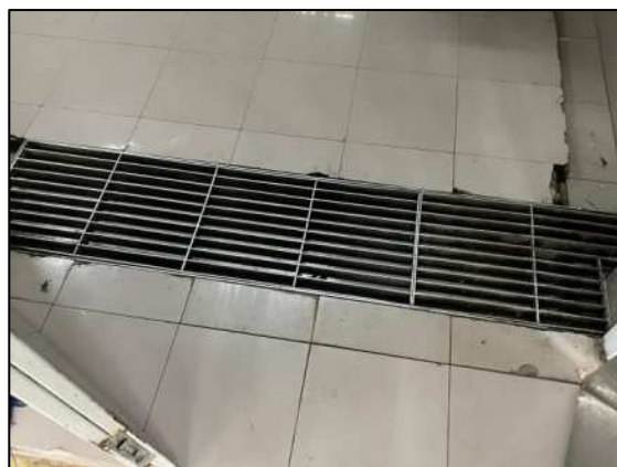
รูปที่ 2-20 รางระบายน้ำภายในห้องพักขยะ
