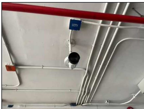
รูปที่ 2-42 การติดตั้งกล้องวงจรปิด(CCTV) กระจายตามจุดต่างๆ
