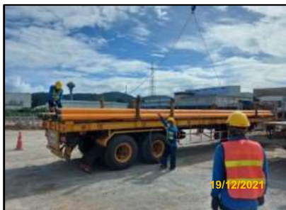
รูปที่ 2-12 การจัดเตรียมความปลอดภัยในการทำงาน สำหรับการขนย้ายและการจัดเก็บท่อส่งก๊าซ
