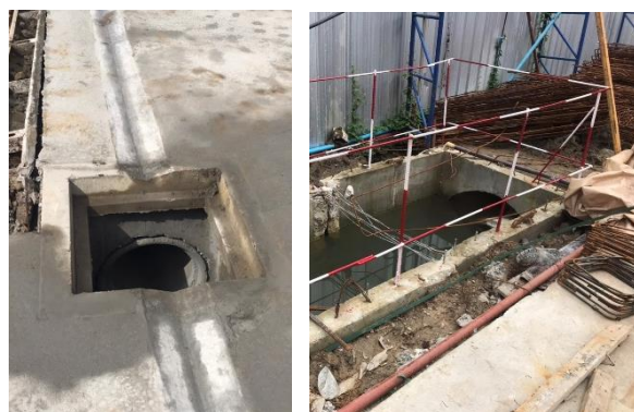
รูปที่ 2-35 ท่อระบายน้ำและปอดักตะกอนดิน
