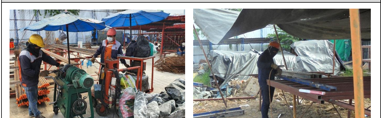
รูปที่ 2-47 พื้นที่สำหรับการเชื่อมตัด โลหะ และที่จัดเก็บวัสดุติดไฟอยู่ในพื้นที่และมีระยะที่เหมาะสม
