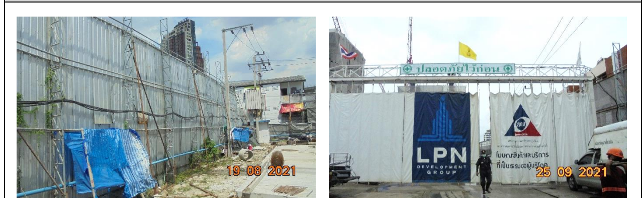
รูปที่ 2-3 รั้ว Metal Sheet ความสูง 6 เมตร โดยรอบพื้นที่ก่อสร้าง และ ประตูทางเข้า-ออก พื้นที่ก่อสร้าง
