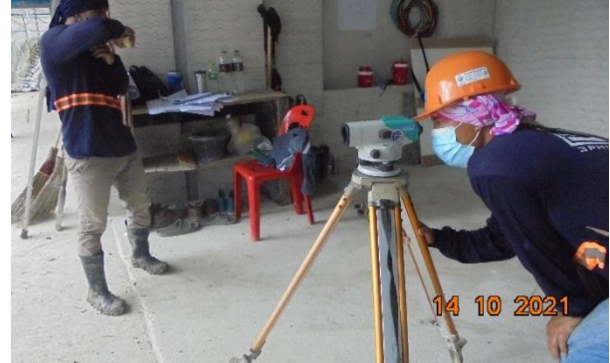
รูปที่ 2-4 การดำเนินงานก่อสร้างเฉพาะภายในขอบเขตโครงการ และการตรวจสอบควบคุมระดับพื้นดินตามแบบแปลนงานก่อสร้าง
