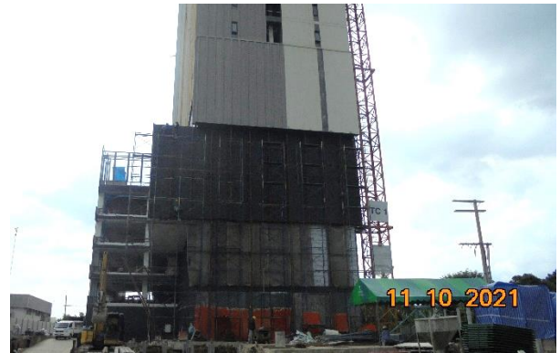
รูปที่ 2-7 ติดตั้ง Mesh Sheet ปิดคลุมรอบตัวอาคาร
