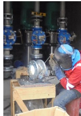
รูปที่ 2-52 พื้นที่สำหรับการเชื่อมตัดโลหะ และที่จัดเก็บวัสดุติดไฟอยู่ในพื้นที่และมีระยะที่เหมาะสม
