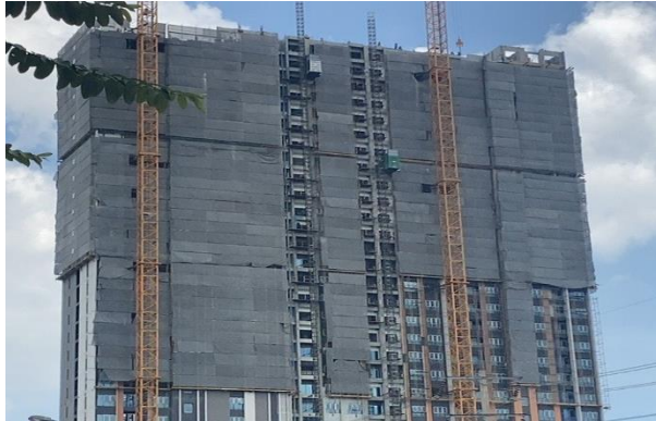
รูปที่ 2-7 ติดตั้ง Mesh Sheet ปิดคลุมรอบตัวอาคาร
