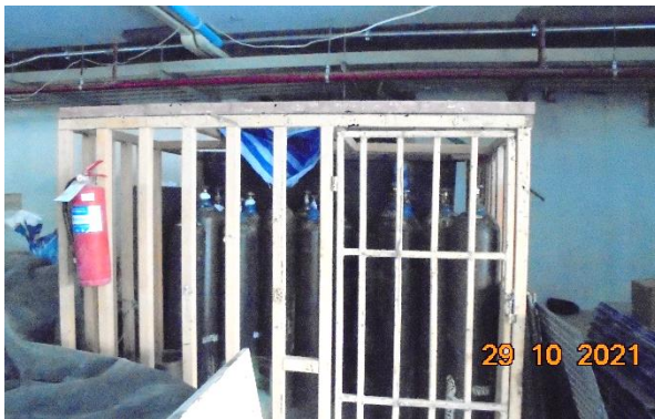
รูปที่ 2-51 พื้นที่เฉพาะสำหรับเก็บเชื้อเพลิง และวัสดุไวไฟ
