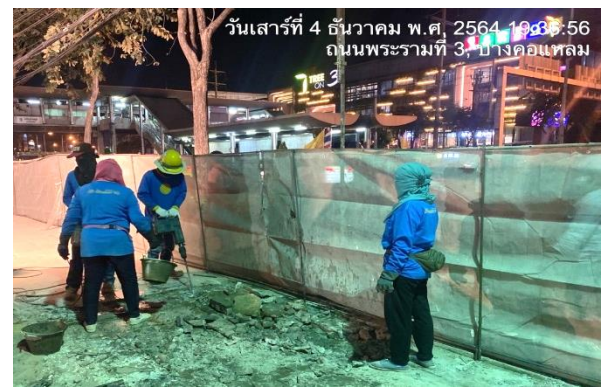
รูปที่ 2-8 การปิดคลุมวัสดุก่อสร้าง การเก็บในพื้นที่ปิดล้อม และฉีดพรมน้ำวัสดุที่มีฝุ่น
