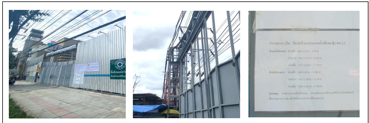
รูปที่ 2-1 รั้ว Metal Sheet สูง 6 เมตร และติดตั้งสปริงเกอร์ตามแนวรั้ว โดยรอบโครงการ
