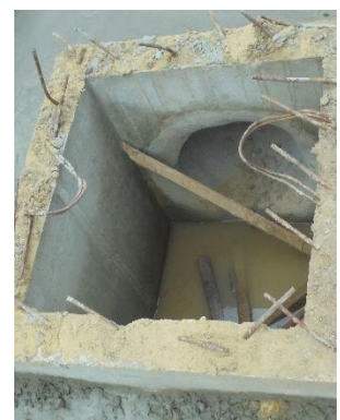
รูปที่ 2-31 ท่อระบายน้ำรอบพื้นที่ก่อสร้าง และบ่อดักตะกอน
