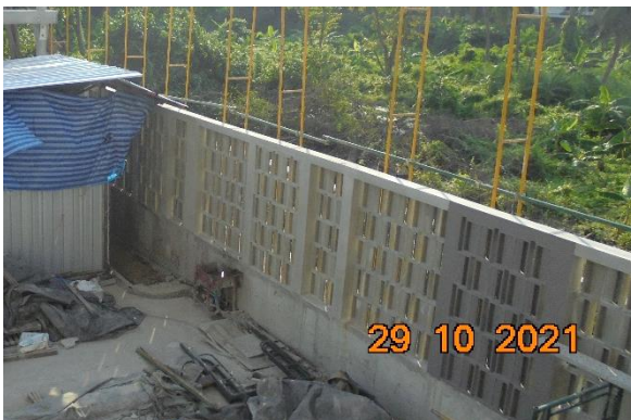
รูปที่ 2-32 รั้วกำแพงกันเศษวัสดุ เพื่อกันเศษวัสดุ จากการก่อสร้างร่วงหล่นลงสู่ด้านล่างโครงข่ายถนนประโยชน์
