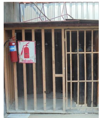
รูปที่ 2-52 พื้นที่สำหรับการเชื่อมตัดโลหะ และที่จัดเก็บวัสดุติดไฟอยู่ในพื้นที่และมีระยะที่เหมาะสม
