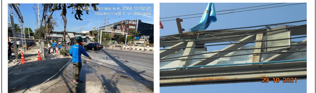
รูปที่ 2-6 การฉีดพรมน้ำบริเวณที่มีการก่อสร้างตามความเหมาะสม และติดตั้งสปริงเกอร์ตามแนวรั้ว
