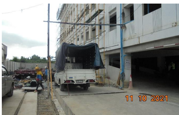
รูปที่ 2-35 พื้นที่ขนถ่ายและเก็บกองวัสดุก่อสร้าง ไม่ให้ล้อเข้าเขตทางสาธารณะ
