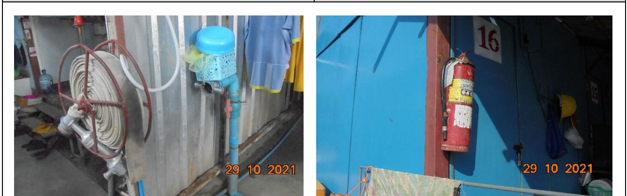
รูปที่ 2-70 หัวฉีดน้ำดับเพลิงและถังดับเพลิงมือถือแบบแห้งบริเวณบ้านพักคนงาน
