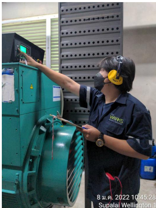
รูปที่ 22 ดำเนินการทดสอบการทำงานของระบบเครื่องกำเนิดไฟฟ้าสำรอง
