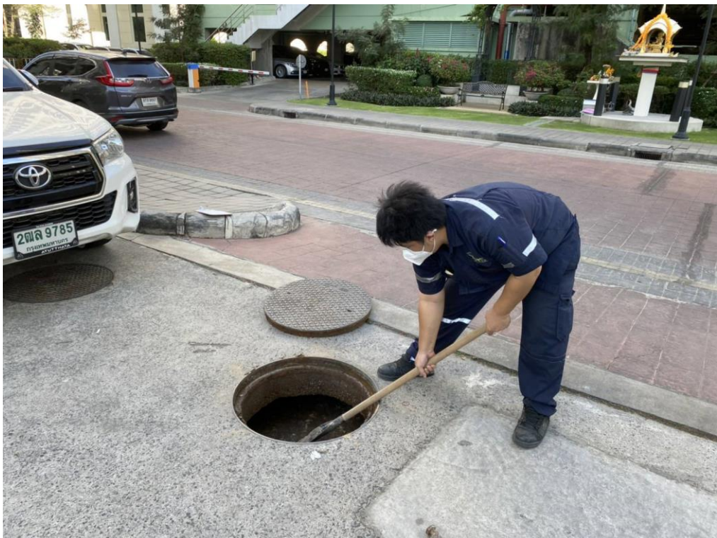
รูปที่ 13 ดำเนินการ ทำการตัดไขมันบ่อบำบัด อาคาร 1-3-5-8
