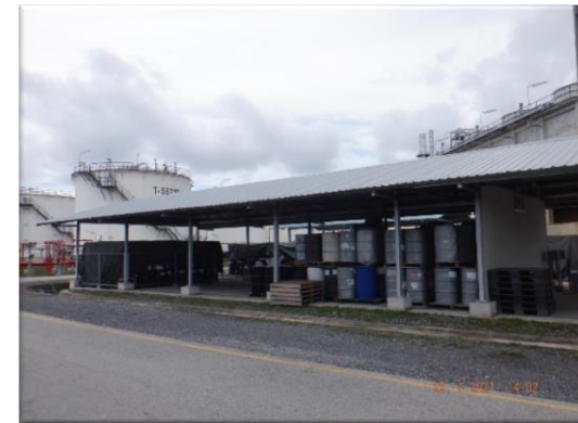
รูปที่ 2-21 อาคารเก็บกากของเสียที่มีหลังคาปกคลุม
