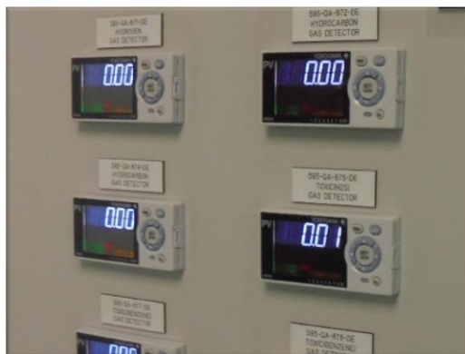
รูปที่ 2-34 Control Panel ที่มีวงจรตรวจจับก๊าซรั่ว ที่สามารถส่งข้อมูลไปยัง จอภาพโทรทัศน์วงจรปิดป้อมยาม ห้องควบคุม และห้อง Safety
