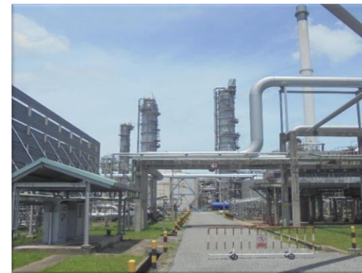
รูปที่ 2-43 การวางท่อบน Pipe Rack หรือ Pipe Bridge ในลักษณะที่ปลอดภัย
