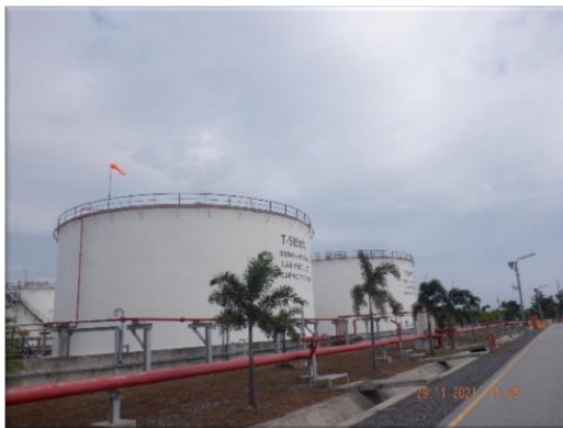
รูปที่ 2-42 คันกั้น (Dike) กั้นรอบบริเวณถังเก็บกัก
