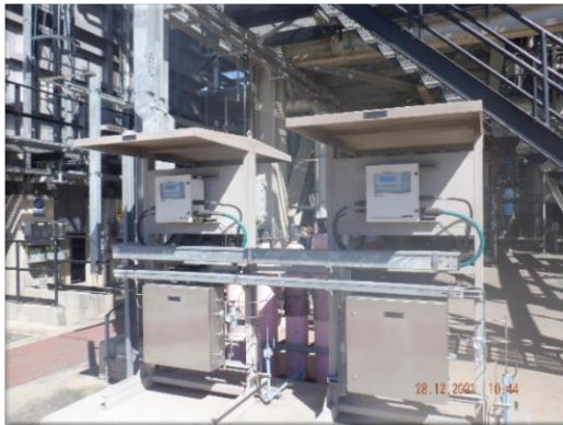
รูปที่ 2-4 การติดตั้งระบบตรวจวัดคุณภาพอากาศแบบต่อเนื่อง (CEMs) ที่ปล่อง Pacol และปล่อง Hot Oil
