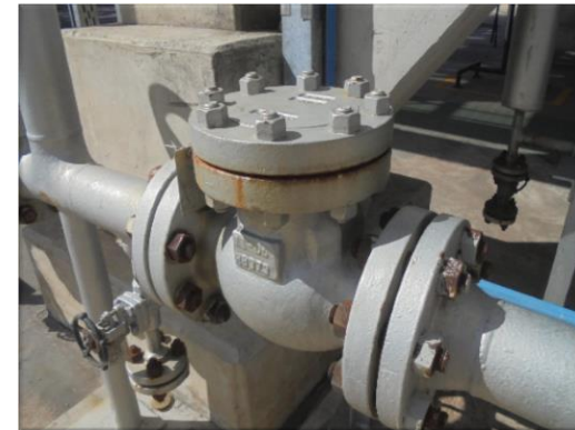
รูปที่ 2-45 Check Valve
