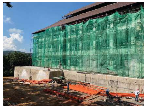
รูปที่ 6 ผ้าใบ Mesh Sheet ปิดกั้นตัวอาคาร
