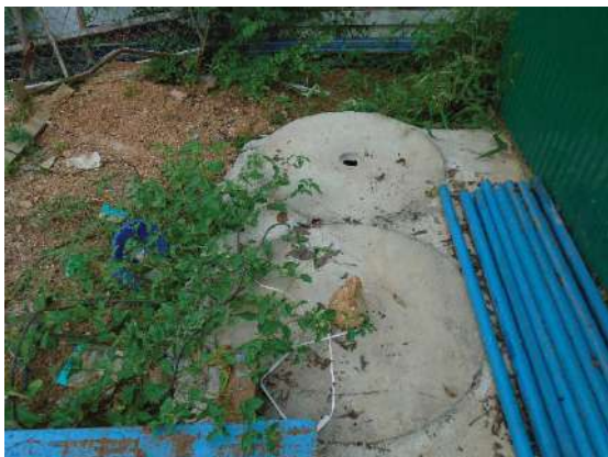
รูปที่ 21 ระบบบำบัดน้ำเสียแบบบ่อเกรอะ-บ่อซึม
