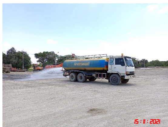
รูปที่ 2-8 การฉีดพรมน้ำบนเส้นทางขนส่งแร่
