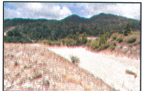
(24) อ่างดักตะกอนที่ 9 ข้าง ใกล้เคียงหน้าเหมือง 5E ขนาดความจุ 2,500 ลบ.ม.
