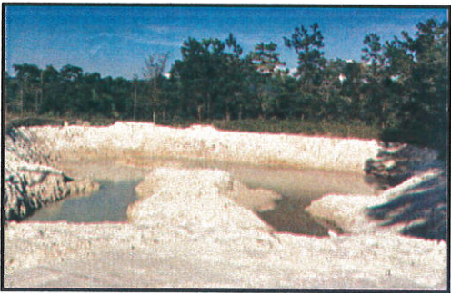
(19) อ่างดักตะกอนจากโรงแต่งแร่และถนน (อ่างดักตะกอนที่ 4 ขนาดความจุ 13,200 ลบ.ม.)
