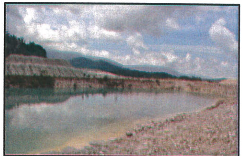
(22) อ่างดักตะกอนที่ 7 ข้าง Stock K ขนาดความจุ 26,400 ลบ.ม.
