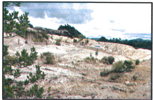
(28) อ่างตกตะกอนที่ 12 ใกล้หน้าเหมือง ขนาดความจุ 10,000 ลบ.ม.
