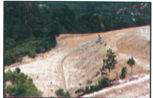
(14) ร่องระบายน้ำลงป่อดักตะกอน 8 (Nort Dump)
