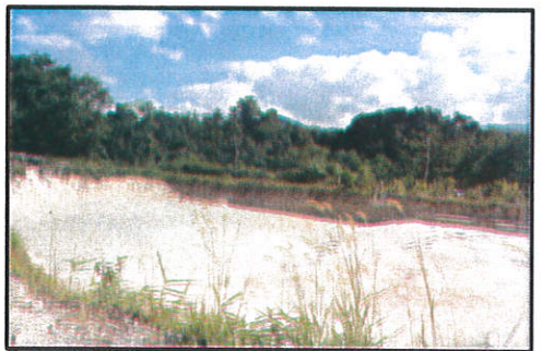
(21) อ่างดักตะกอนที่ 6 (ขนาดความจุ 10,500 ลบ.ม)
