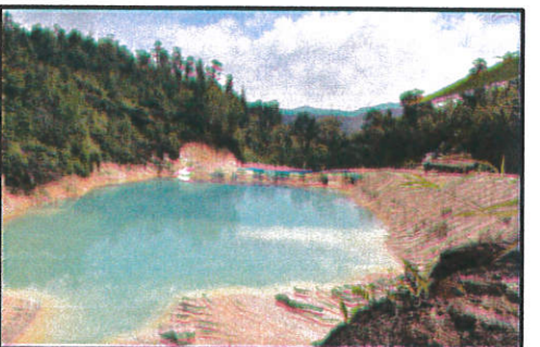
(23) อ่างดักตะกอนที่ 8 บริเวณที่ทิ้งดิน ด.3 ขนาดความจุ 6,000 ลบ.ม.
