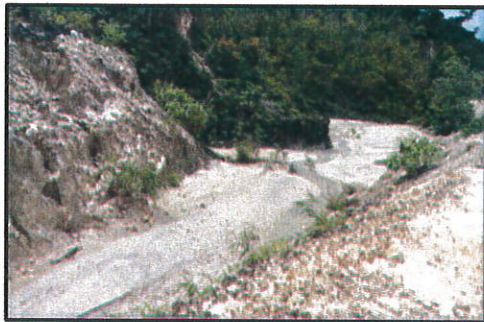
(27) อ่างตกตะกอนที่ 12 ใกล้ South Dump ขนาดความจุ 2,250 ลบ.ม.
