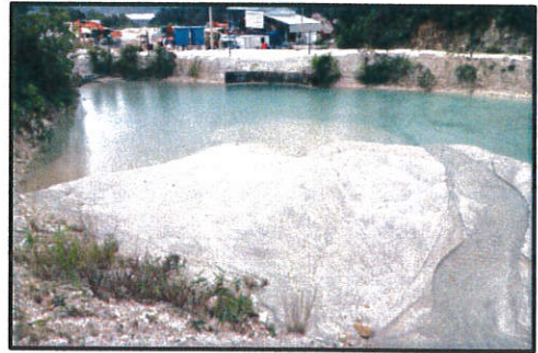
(26) อ่างตกตะกอนที่ 11 ข้าง Stock G ขนาดความจุ 4,900 ลบ.ม.
