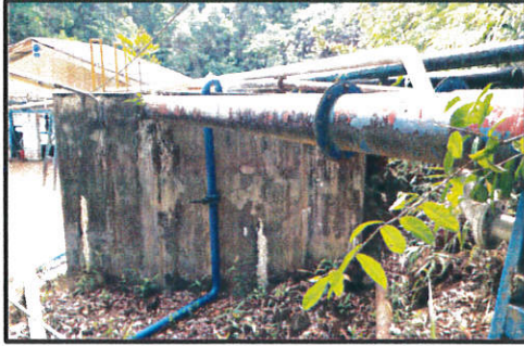
(33) ท่อระบายน้ำจากโรงแต่งที่ลงบ่อดักตะกอนคอนกรีต
