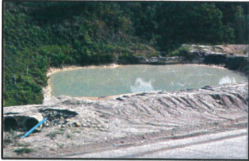
(17) อ่างดักตะกอนบริเวณลานสต็อกวัตถุดิบ (อ่างดักตะกอนที่ 2 ขนาดความจุ 5,400 ลบ.ม)
