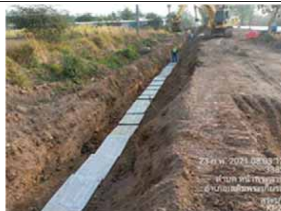
รูปที่ 2-13 การจำกัดพื้นที่ก่อสร้างเฉพาะบริเวณที่ได้รับอนุญาต และการติดตั้ง Warning tape และติดตั้ง Concrete slab
