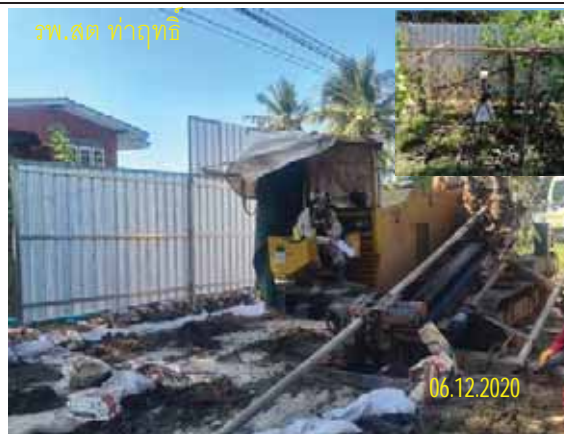
การติดตั้งกำแพงกันเสียงบริเวณพื้นที่บ่อรับ-ปล่อย และการตรวจสอบระดับเสียงหลังติดตั้งกำแพง
