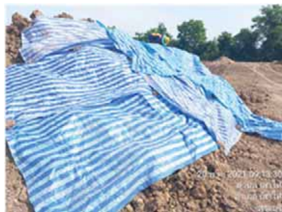
รูปที่ 2-6 การติดตั้งแผงวัสดุป้องกันฝุ่น การฉีดพรมน้ำที่กองดินและการปิดคลุมกองดิน
