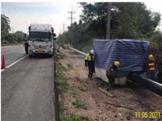
ฉ) การปิดกั้นพื้นที่ทำการ Sand Blast
