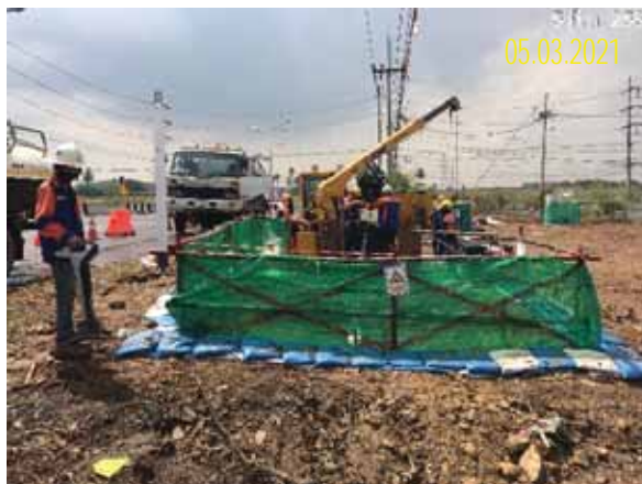
ข) กิจกรรมการก่อสร้างด้วยวิธีเจาะลอดบริเวณ HDD#8
