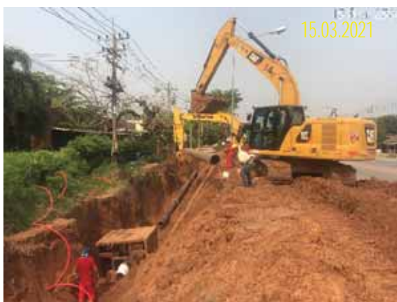
ค) กิจกรรมงานขุดเปิดและฝังกลบท่อ โดยมีการติดตั้ง Trench box บริเวณ KP 145
