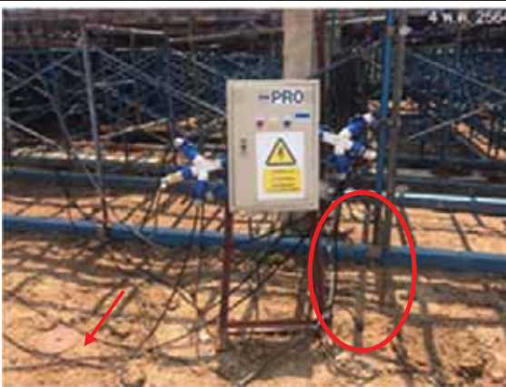
ค) การติดตั้งสายดิน และตรวจวัดกระแสตามมาตรฐานความปลอดภัย
