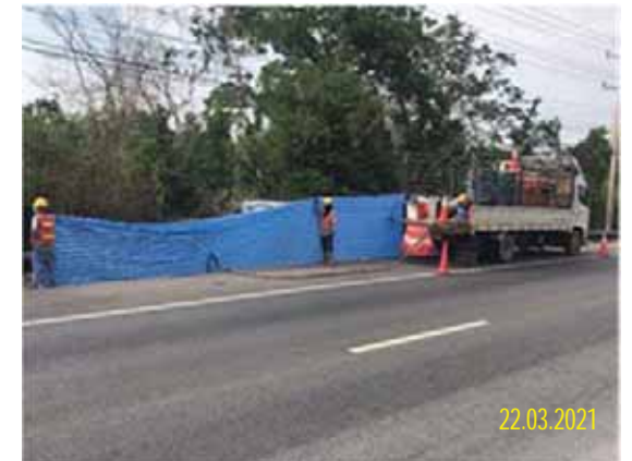
ฉ) การปิดกั้นพื้นที่ทำการ Sand Blast
