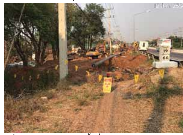
ฉ) กิจกรรมการปิดล้อมพื้นที่สำหรับการตรวจสอบรอย เชื่อมด้วยวิธี X-Ray บริเวณ KP 145
