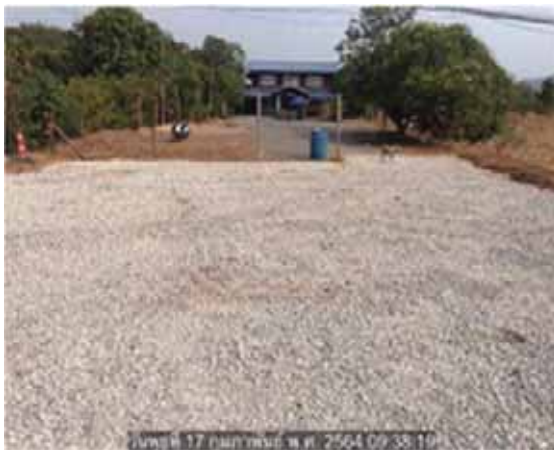
รูปที่ 2-9 การจัดทำพื้นที่ล้างล้อพร้อมทั้งล้างทำความสะอาดเศษดิน และเศษโคลนที่ติดกับล้อรถ ก่อนออกจากพื้นที่เก็บกองท่อ (Stock Yard) และคลังน้ำมันปลายทางขอนแก่น
