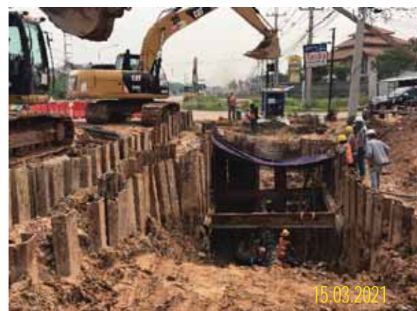
ง) กิจกรรมงานขุดเปิดและฝังกลบท่อ โดยมีการติดตั้ง Sheet pile บริเวณ KP 257
