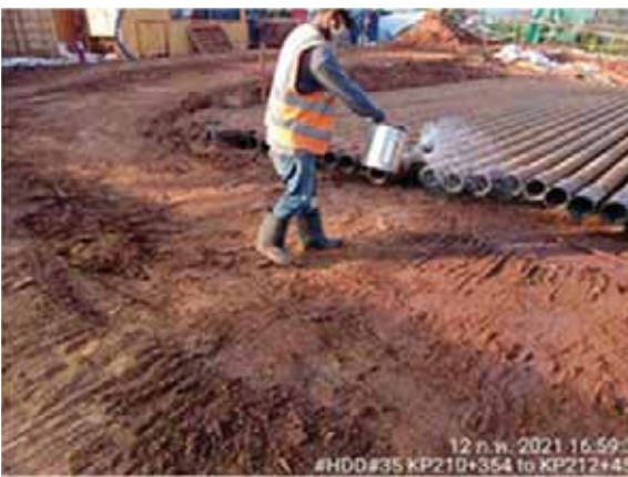
รูปที่ 2-4 การฉีดพรมน้ำเพื่อลดการฟุ้งกระจายของฝุ่นละออง
