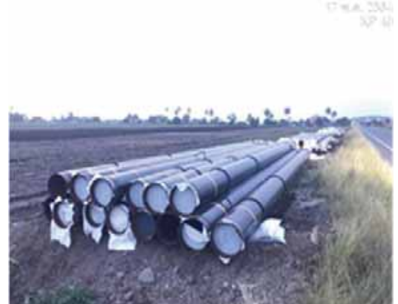
รูปที่ 2-25 การจัดวางวัสดุอุปกรณ์และท่อในบริเวณที่เหมาะสมเป็นระเบียบเรียบร้อย
