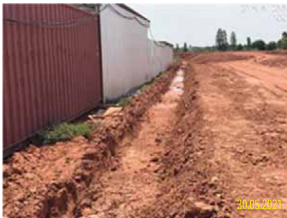
รูปที่ 2-29 การระบายน้ำและการจัดทำบ่อพักน้ำ
