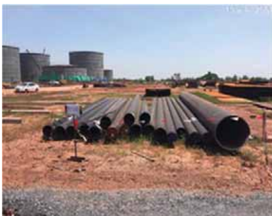
รูปที่ 2-25 การจัดวางวัสดุอุปกรณ์และท่อในบริเวณที่เหมาะสมเป็นระเบียบเรียบร้อย
