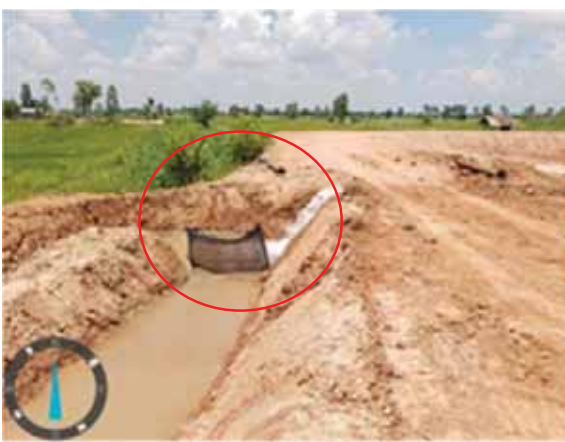
รูปที่ 2-27 การจัดทำทางเบี่ยงเบนทิศทางการไหลของน้ำและการวางท่อลอดถนนทางเข้าชั่วคราว
