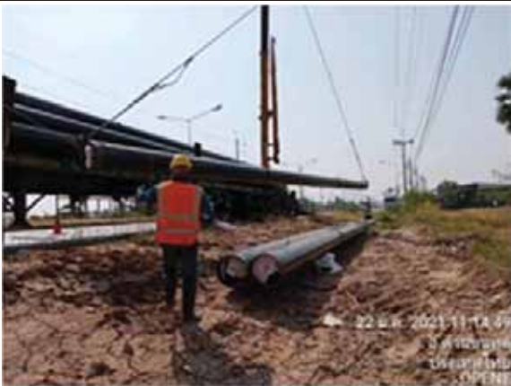
ค) การจัดวางท่อส่งน้ำมัน และวัสดุป้องกันการพังทลาย
