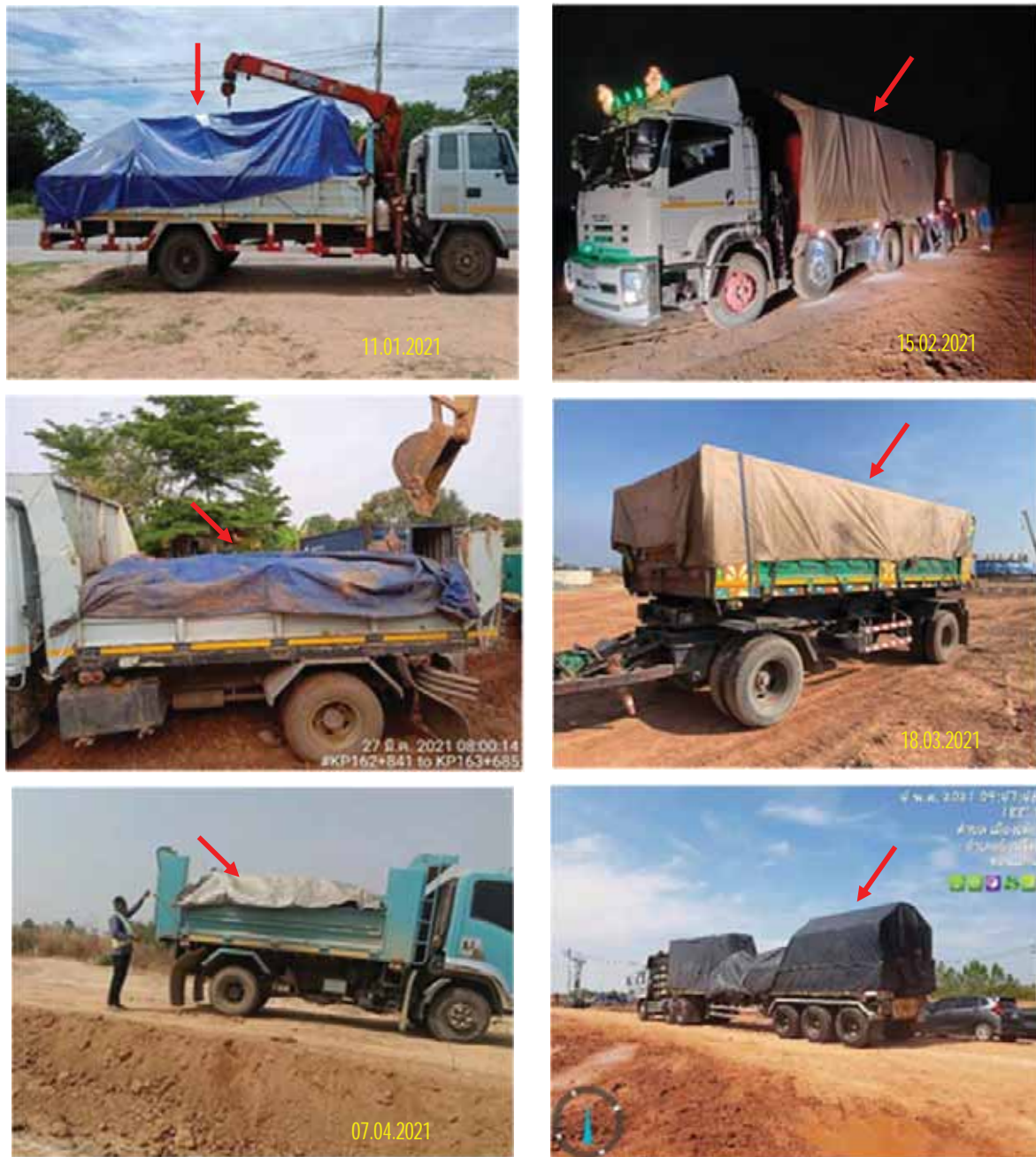
รูปที่ 2-5 การใช้ผ้าใบปิดคลุมรถบรรทุกระหว่างการขนย้ายวัสดุ
