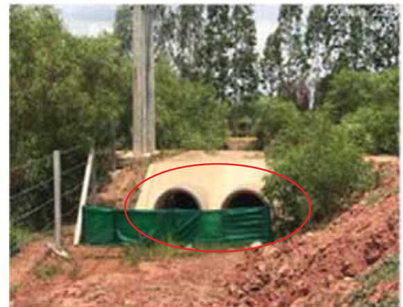
รูปที่ 2-27 การจัดทำทางเบี่ยงเบนทิศทางการไหลของน้ำและการวางท่อลอดถนนทางเข้าชั่วคราว
