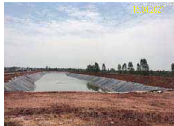
ฉ) การทำบ่อพักน้ำสำหรับพื้นที่ก่อสร้างคลังน้ำมัน จังหวัดขอนแก่น
