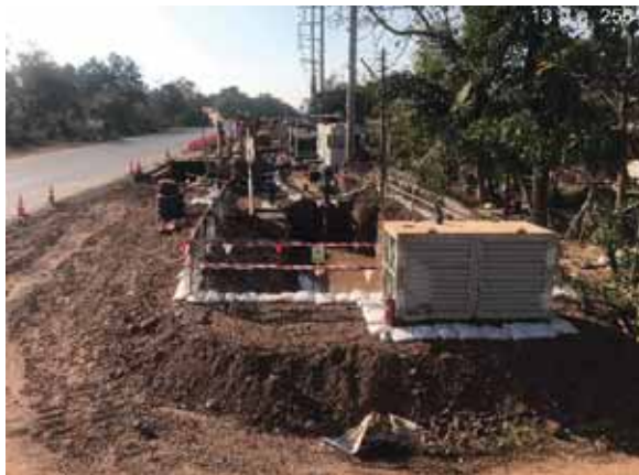
ค) การติดตั้งทุบทรายที่บ่อส่งในพื้นที่เจาะลวด KP 125
