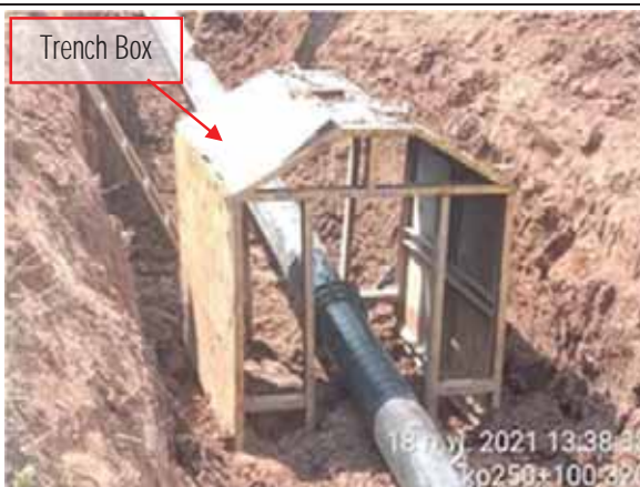
รูปที่ 2-15 การติดตั้ง Sheet Pile หรือ Trench box เพื่อป้องกันการพังทลายของดิน
