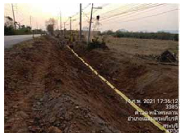
รูปที่ 2-13 การจำกัดพื้นที่ก่อสร้างเฉพาะบริเวณที่ได้รับอนุญาต และการติดตั้ง Warning tape และติดตั้ง Concrete slab
