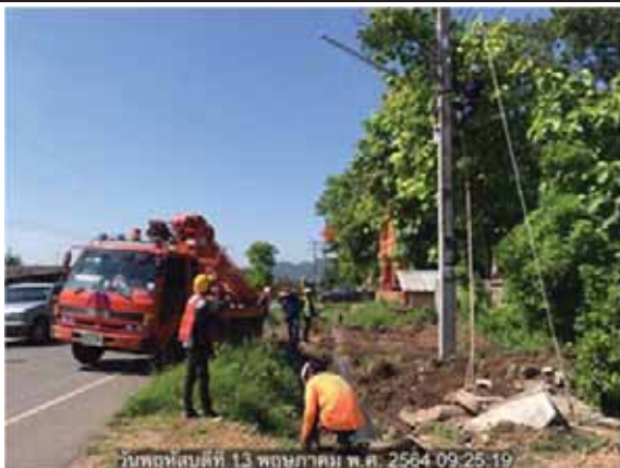
ก) เจ้าหน้าที่ไฟฟ้าพัฒนาคมนเข้าปักเสาและรื้อย้ายเสาไฟฟ้าบริเวณพื้นที่ก่อสร้าง
