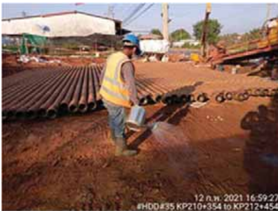
รูปที่ 2-4 การฉีดพรมน้ำเพื่อลดการฟุ้งกระจายของฝุ่นละออง
