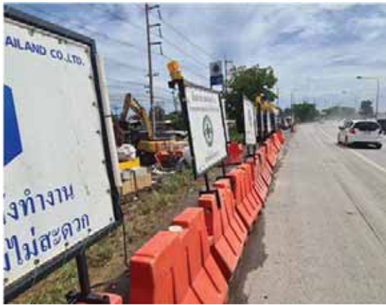
ก) การติดตั้งป้ายเตือนและกั้นเขตพื้นที่ก่อสร้าง
