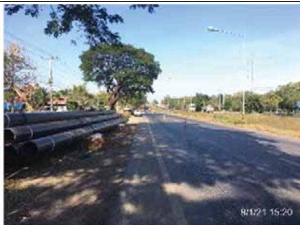
ง) เก็บกองท่อและอุปกรณ์ก่อสร้างอย่างเป็นระเบียบเรียบร้อย
