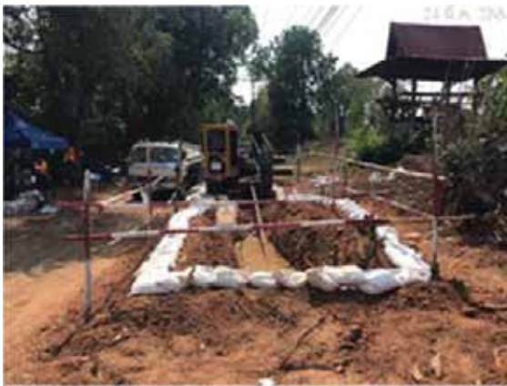
ข) จัดวางถุงทรายหรือจัดทำคันดินกันรอบพื้นที่บ่อรับ-ปล่อย
