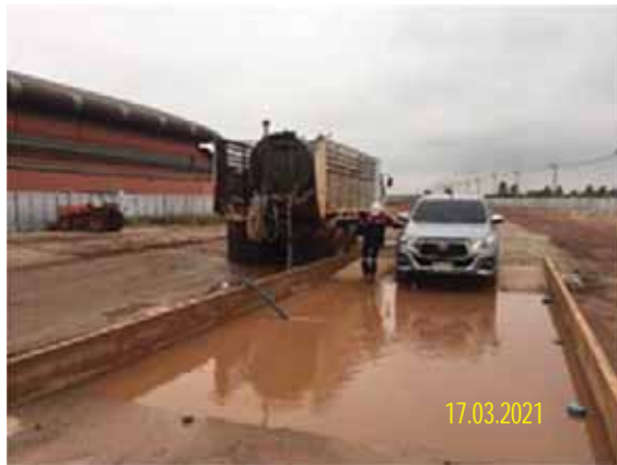
รูปที่ 2-9 การจัดทำพื้นที่ล้างล้อพร้อมทั้งล้างทำความสะอาดเศษดิน และเศษโคลนที่ติดกับล้อรถ ก่อนออกจากพื้นที่เก็บกองท่อ (Stock Yard) และคลังน้ำมันปลายทางขอนแก่น
