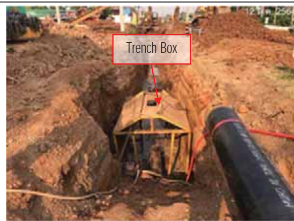
รูปที่ 2-15 การติดตั้ง Sheet Pile หรือ Trench box เพื่อป้องกันการพังทลายของดิน
