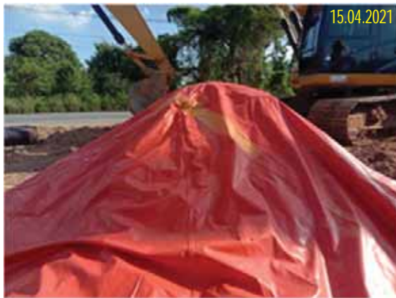
รูปที่ 2-6 การติดตั้งแผงวัสดุป้องกันฝุ่น การฉีดพรมน้ำที่กองดินและการปิดคลุมกองดิน
