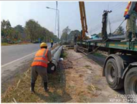
ค) การจัดวางท่อส่งน้ำมัน และวัสดุป้องกันการพังทลาย
