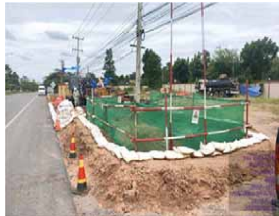
ข) จัดวางถุงทรายหรือจัดทำคันดินกันรอบพื้นที่บ่อรับ-ปล่อย
