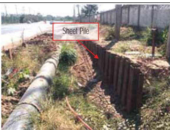
รูปที่ 2-14 การทำพูนดิน (Crown) บริเวณพื้นที่หลังท่อ
