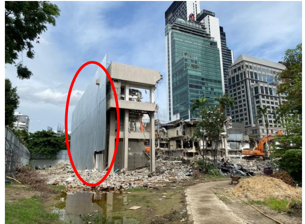
รูปที่ 2.9 Metal Sheet ห่างจากแนวอาคารรื้อถอน
