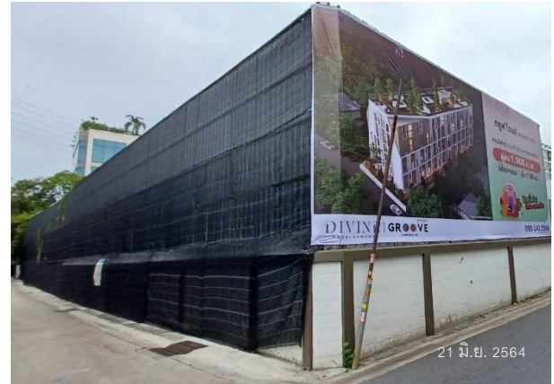
รูปที่ 2.1 รั้ว Metal Sheet ความสูง 6 เมตร
