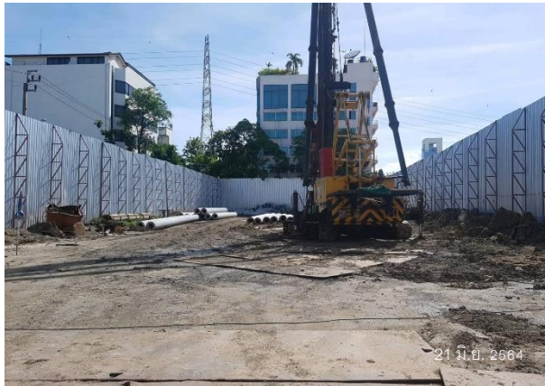
รูปที่ 2.1 รั้ว Metal Sheet ความสูง 6 เมตร
